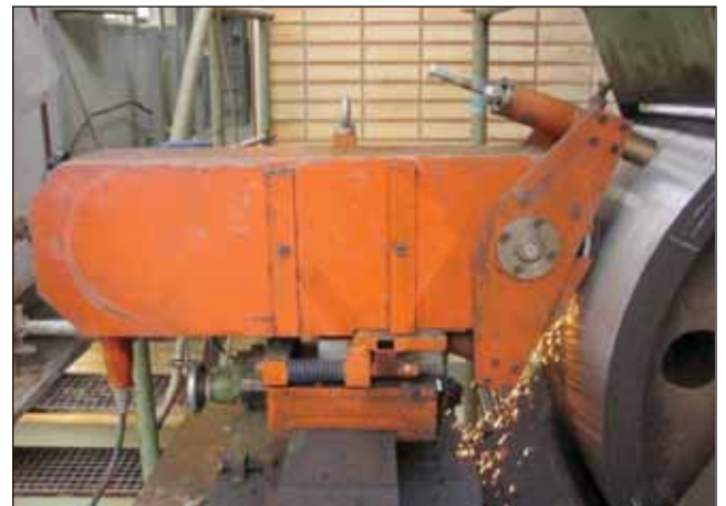
Korrigieren der Oberflächen von Laufringen
