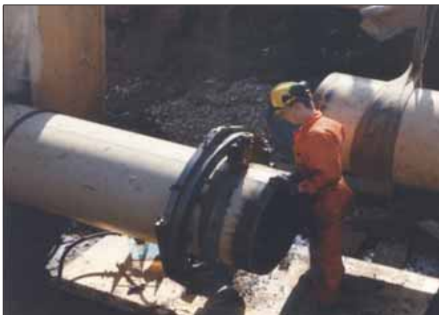
Anpassungsarbeiten zum Verbinden von Rohren
