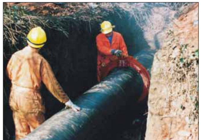
Vorbereitung für Schweißnahtverbindungen
