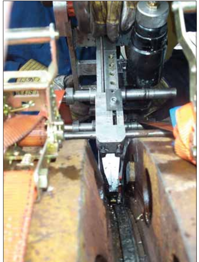
Schweißlippentrennung vor Ort
