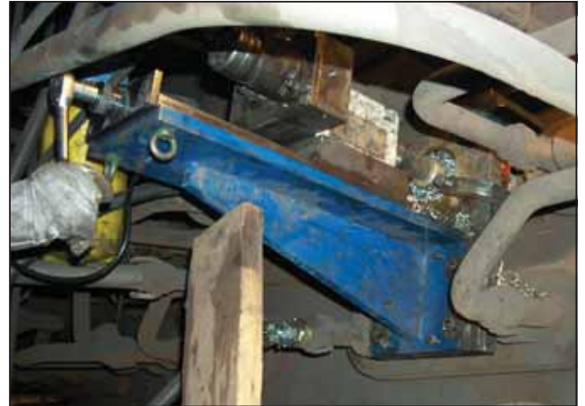
Einbringen einer Bohrung im Durchmesserbereich vom 150 mm an einem Hochofenmantel
