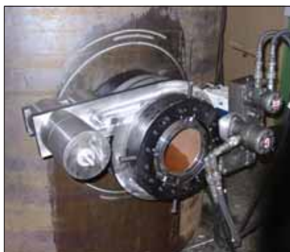
Ausstechen eines Stutzen an einem Behälter mit gleichzeitiger Schweißnahtvorbereitung
