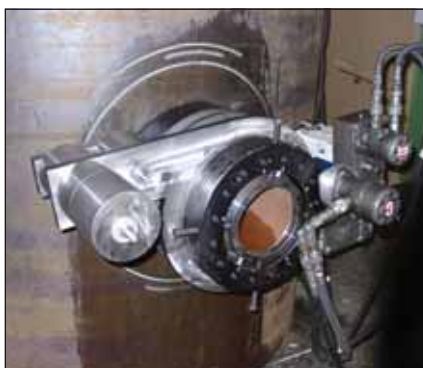
Carottage avec chanfrein de soudure sur un caisson
