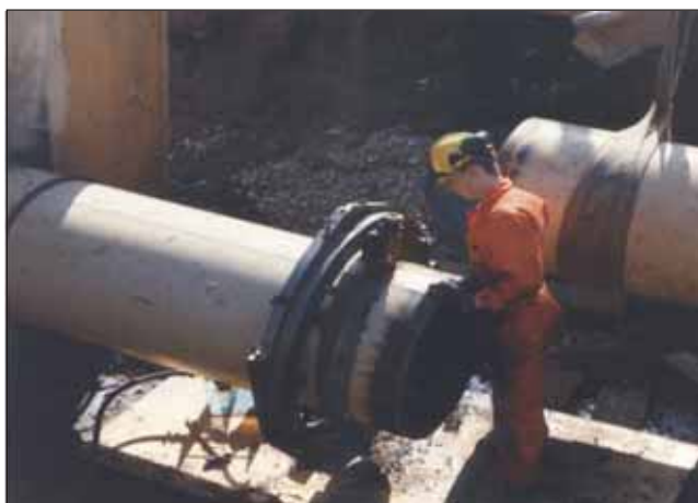
Mise en longueur de 2 tubes pour raccordement
