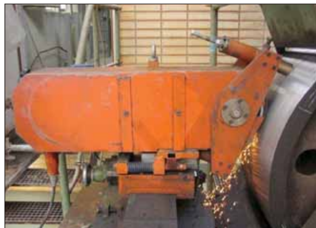
Remise en état d'une surface de roulement
