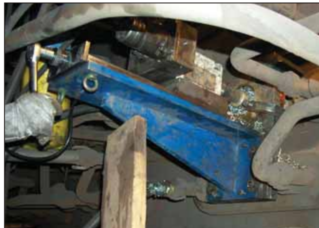
Perçage d'un diamètre 150 mm dans une paroi de haut fourneau
