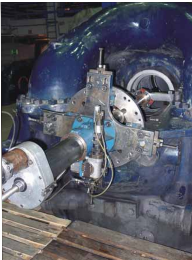
Alésage en ligne sur une turbine
