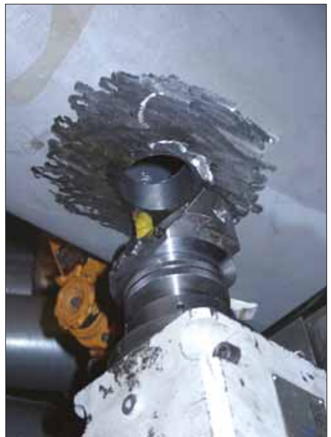
Alésage d'un piquage sur un pipe
