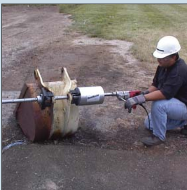
Schritt 3: Antrieb befestigen und das Innenausdrehen starten
